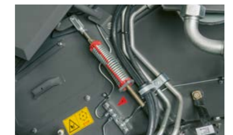
Points de graissage regroupés en bancs de graissage centralisés et parfaitement matérialisés
